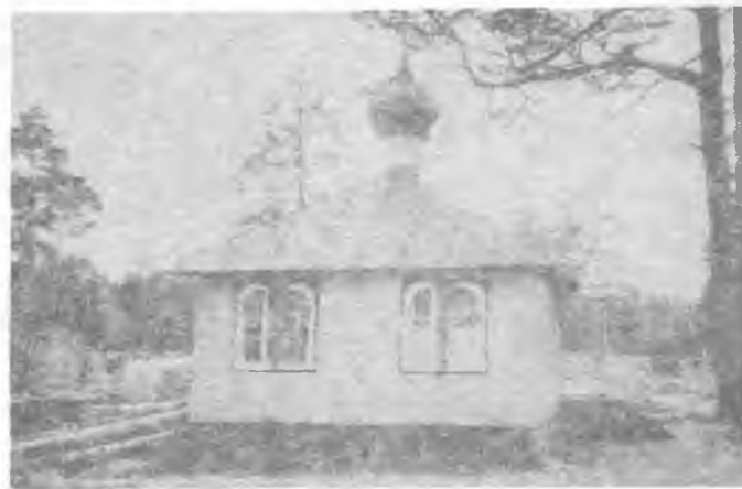
Часовня и вновь строящийся каменный храм на Северном (б. Успенском) кладбище.
