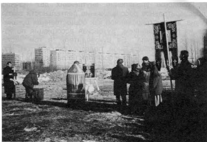
Закладка церкви Державной иконы Божией Матери при Областной клинической больнице
