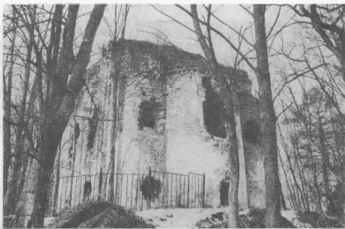
Иоанно-Богословский собор (Алтарная часть). Современный вид
