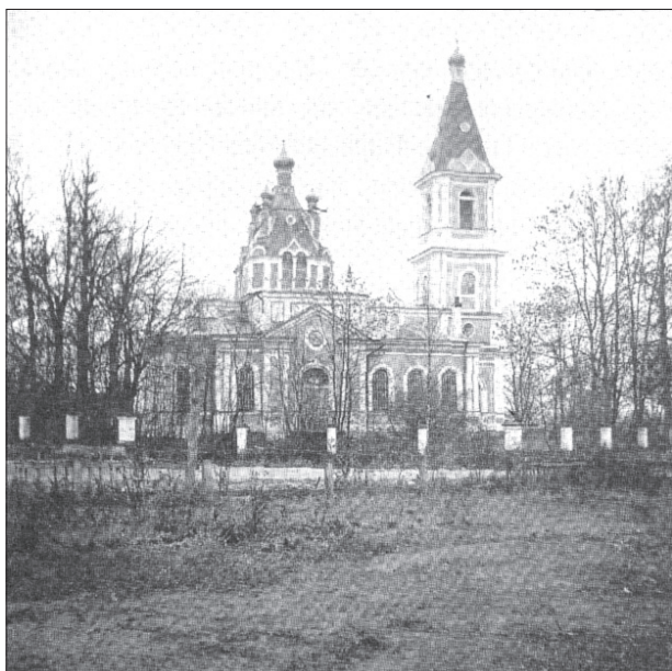
Ильеши. Николо-Параскевинский храм. Вид с северной стороны
