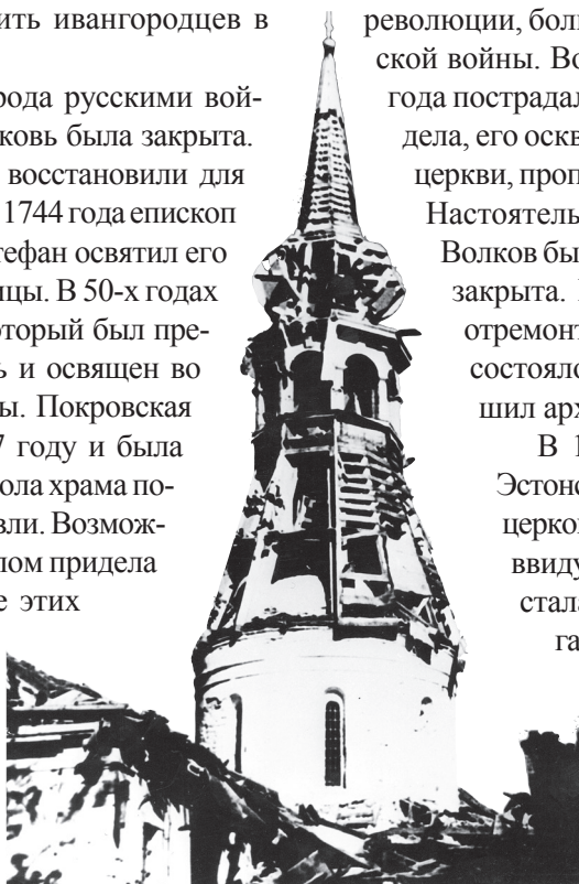
Разрушенная колокольня Успенской церкви. 1944 г.
