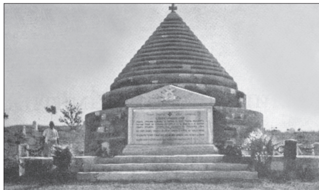
Памятник, сооруженный в Галлиполи в 1921 г.
