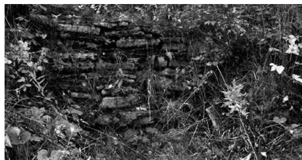
Любша. Фрагмент крепостной стены
